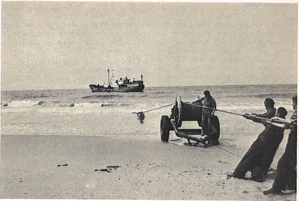
Het leggen van de aardkabels te Domburg.
